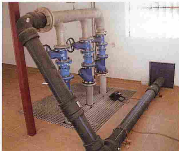
Imagen 3: Abarcones del colector de aguas bombeadas, a la derecha abajo. Fuente: Elaboración propia
