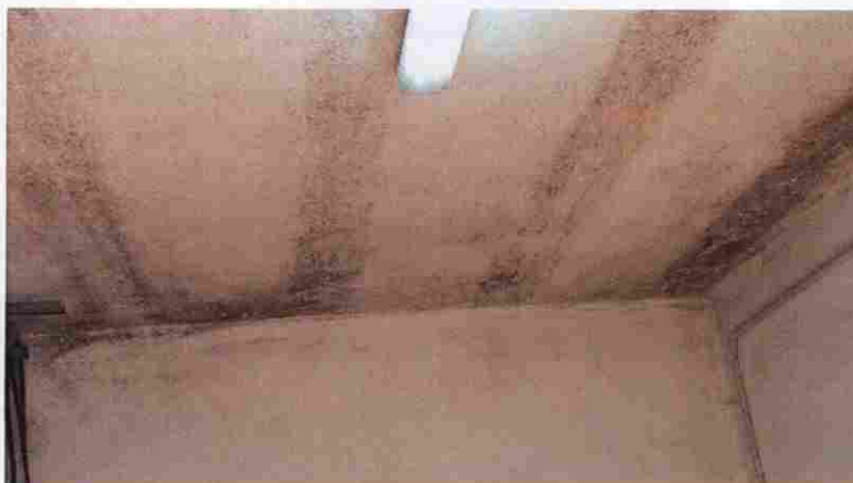
Imagen 14: Humedades en el techo. Fuente: Elaboración propia
