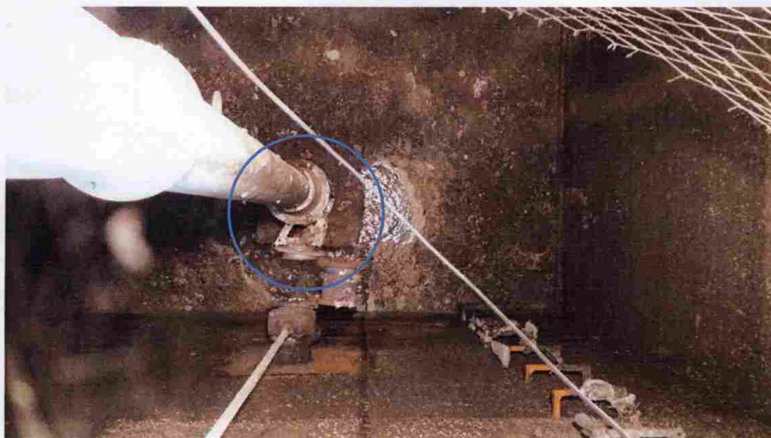
Imagen 16: Disposición actual del tamiz de finos, obsérvese el pilar donde apoya dentro del círculo azul. Fuente: Elaboración propia
