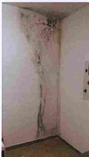
Imagen 13: Humedades en la pared. Fuente: Elaboración propia
