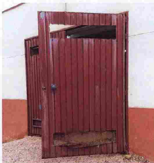
Imagen 9: Hoja de la puerta de acceso, nótese el mal estado de la rejilla inferior. Fuente: Elaboración propia
