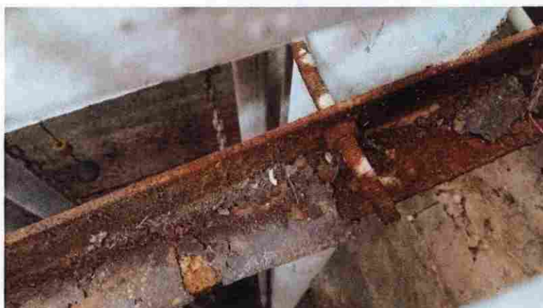
Imagen 8: Viga de sujeción de las conducciones del bombeo. Fuente: Elaboración propia
